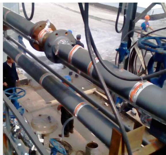
Обогреваемые трубопроводы могут располагаться как над землей, так и под землей на глубине промерзания грунта. Такие трубы максимально подвержены прямому воздействию холода, поэтому их необходимо дополнительно защищать теплоизоляцией.
